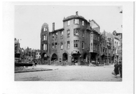
Kriegszerstörtes ADGB-Haus am Nordwall 125
